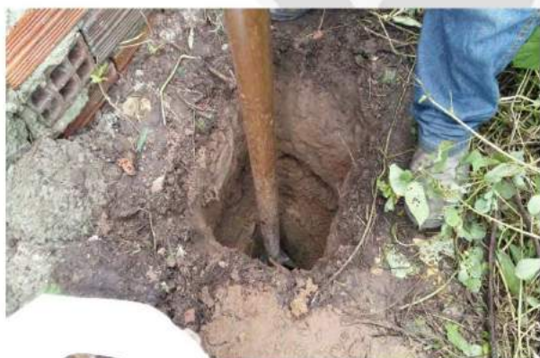
Foto 3 – Detalhe do furo finalizado e dos horizontes de materiais de subleito.
