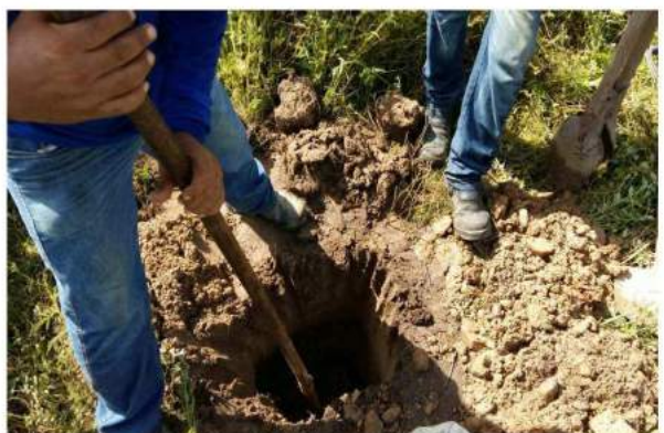
Foto 5 – vendo-se o detalhe do poço de sondagem a pá e picareta em andamento.
